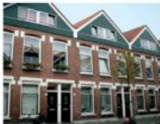
Houten ramen vervangen door aluminium. PK. Drossaertstraat Vlaardingen
